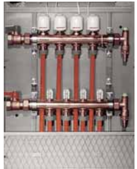
6. Detail připojení trubek k rozdělovací stanici
