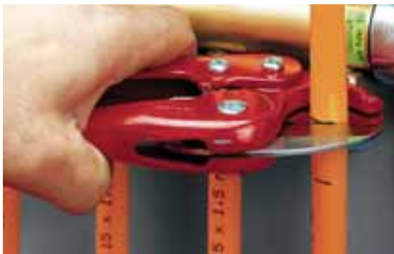
6b. Úprava délky trubky na horní značce
