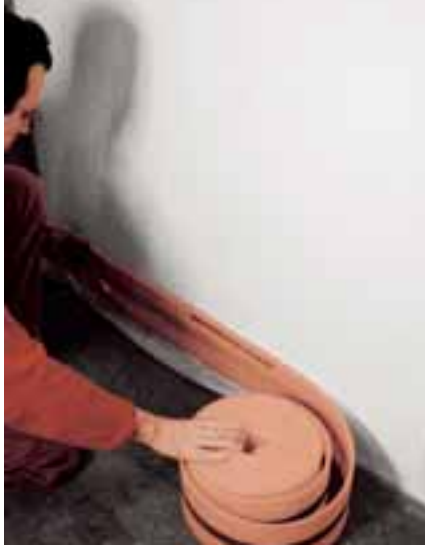
1. Položení dilatačních pásů
