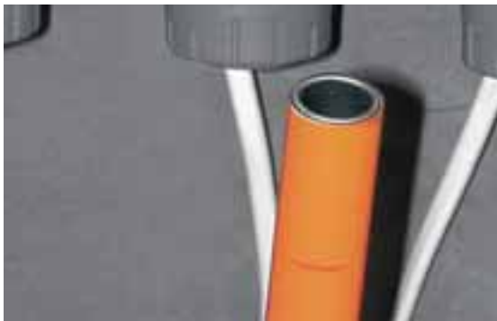
6d. Kontrola usazení opěrného pouzdra
