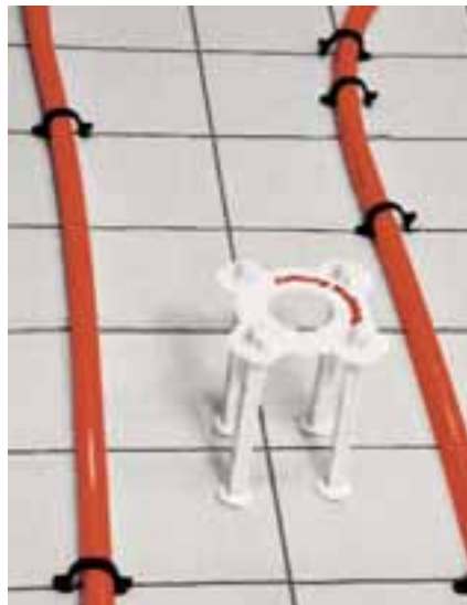
5. Označení místa pro zjišťování zbytkové vlhkosti potěru
