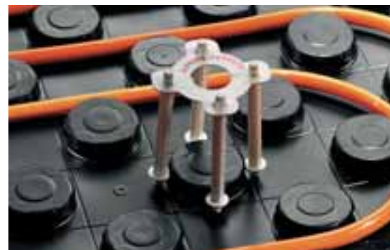
5e. Vytvoření měřicího místa k změření zbytkové vlhkosti potěru (v okruhu přibližně 10 cm nesmějí být žádné trubky).
