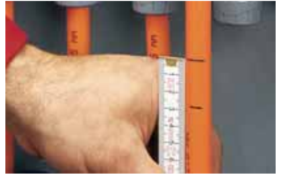
6a. Označení hloubky zasunutí 27 mm
