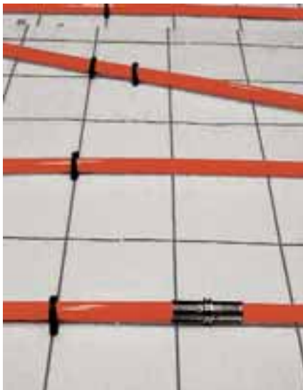
4. Detail uložení trubek na systémovém pásu
