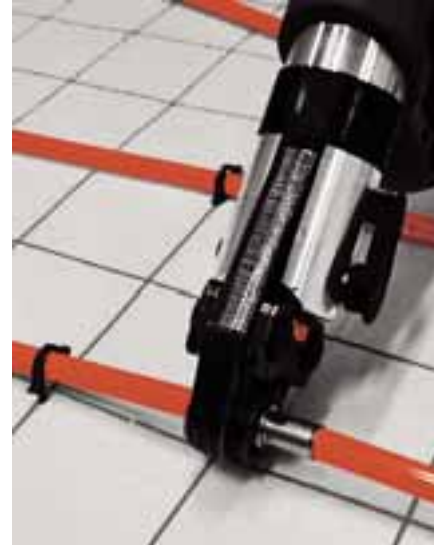
3. Spojení trubek lisovaným spojem
